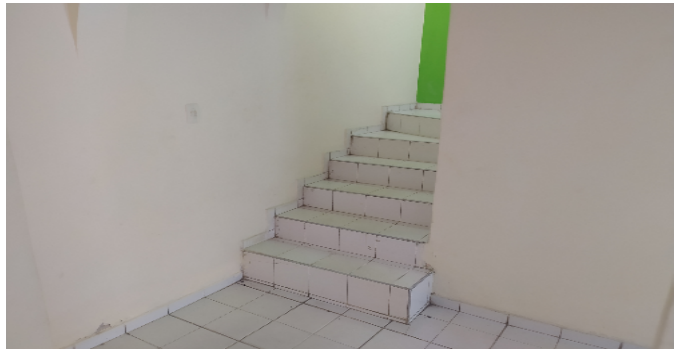
Escalera del inmueble
