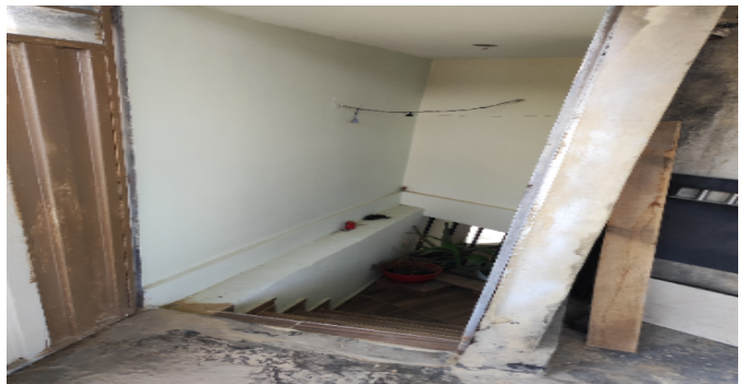
Escalera del inmueble
