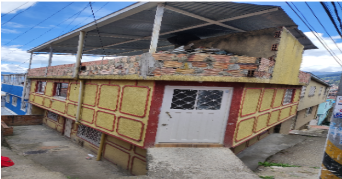
Fachada del Inmueble
