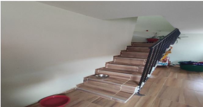
Escalera del inmueble
