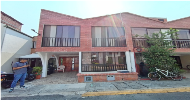
Fachada del Inmueble
