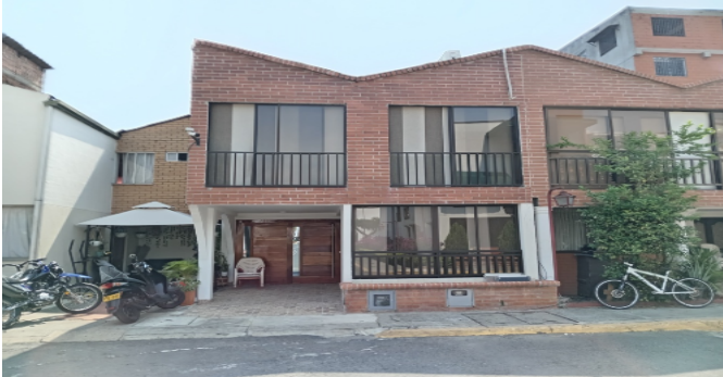
Fachada del Inmueble
