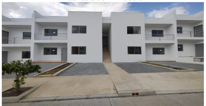
Fachada del Inmueble
