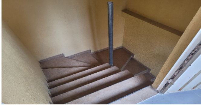
Escalera común CJ
