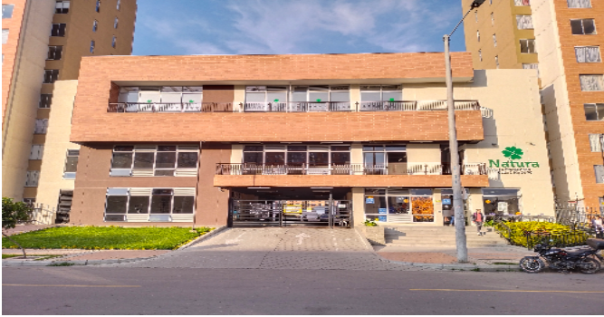
Fachada del Conjunto
