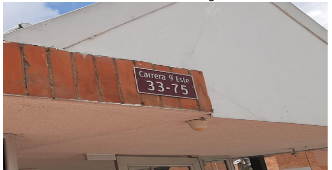
Contador de Energia
