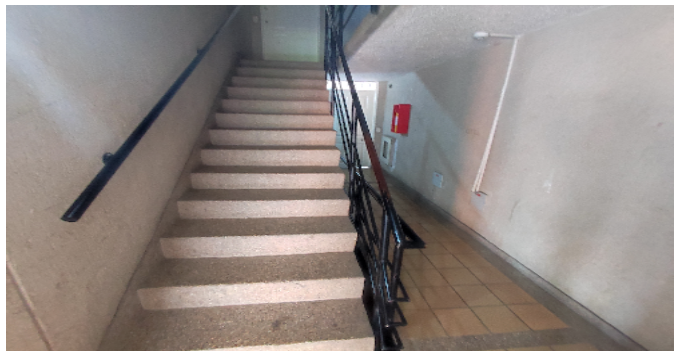
Escalera común CJ
