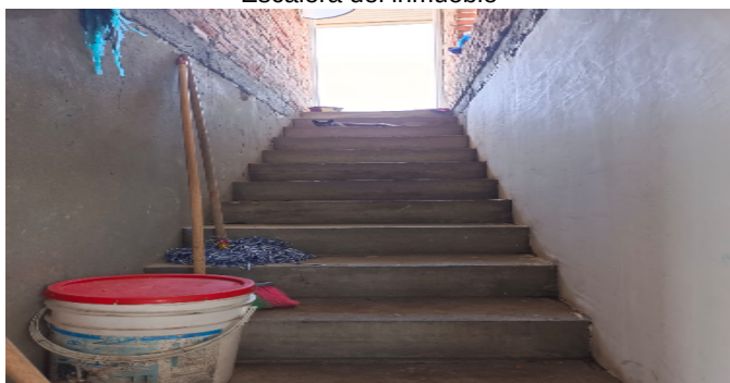
Escalera del inmueble
