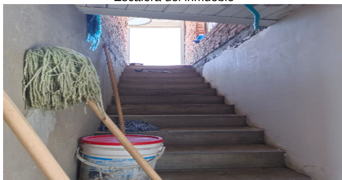
Escalera del inmueble
