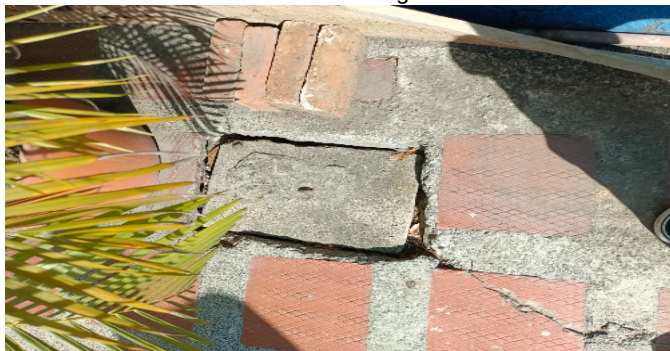
Contador de Agua
