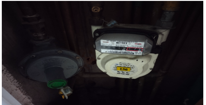
Contador de Gas
