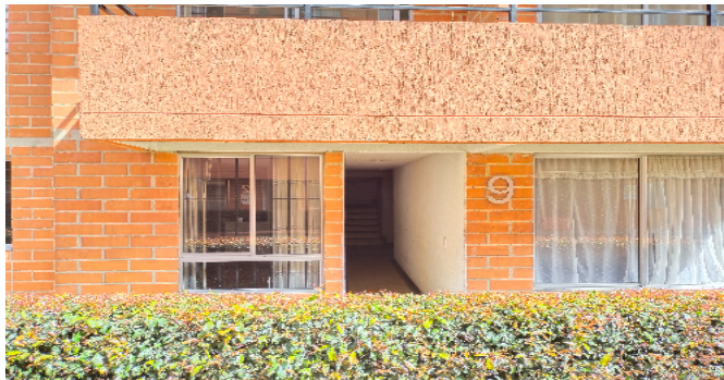
Entrada de la torre
