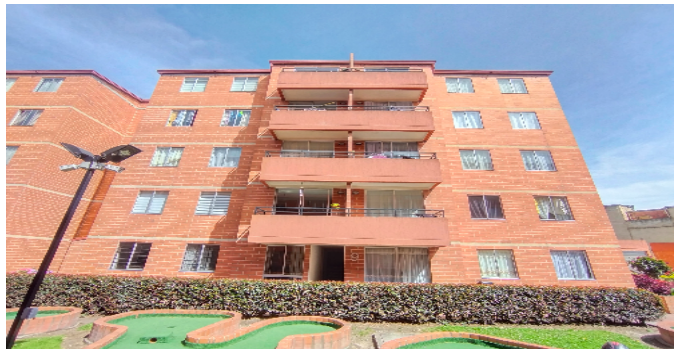
fachada de la torre
