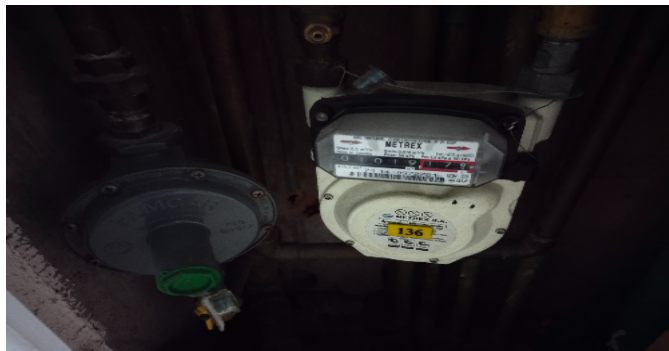
Contador de Gas
