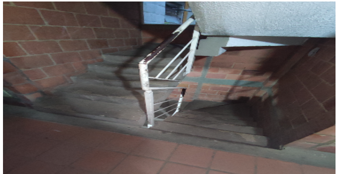
Escalera común CJ
