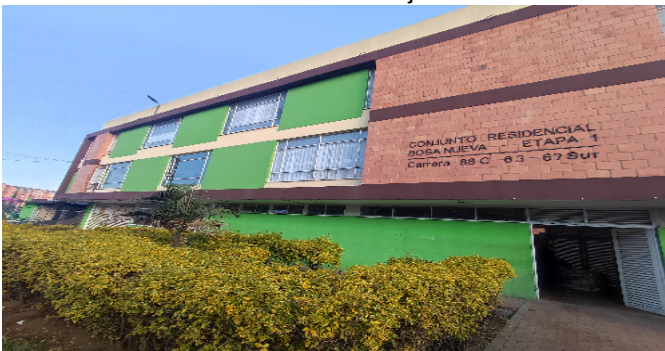
Fachada del Conjunto
