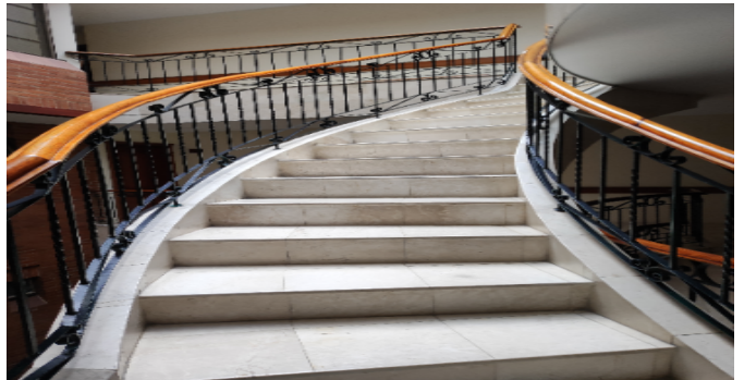
Escalera común CJ
