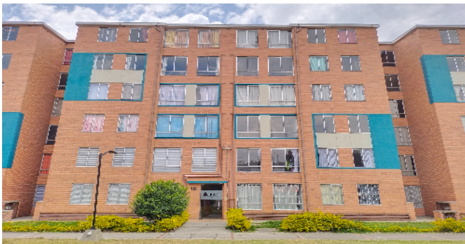
Fachada de la torre
