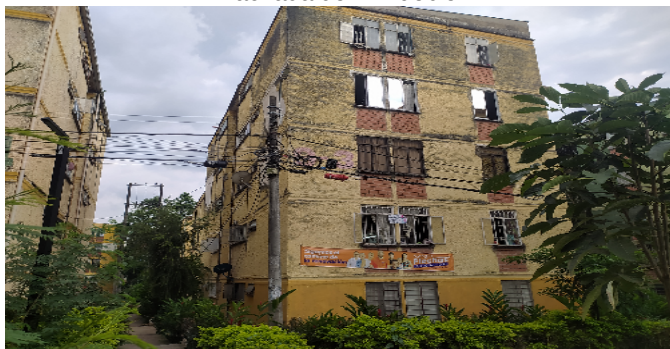
Fachada del Inmueble
