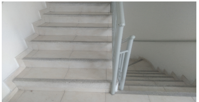
Escalera común CJ
