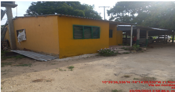
Fachada del Inmueble
