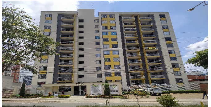
Fachada del Inmueble
