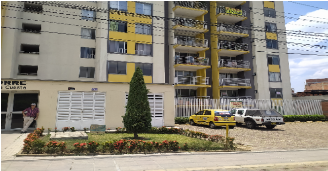
Fachada del Inmueble
