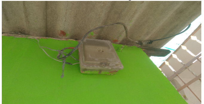
Contador de Energia
