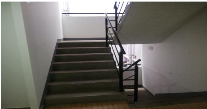
Escalera común CJ
