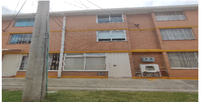
Fachada del Inmueble
