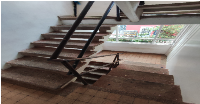
Escalera común CJ
