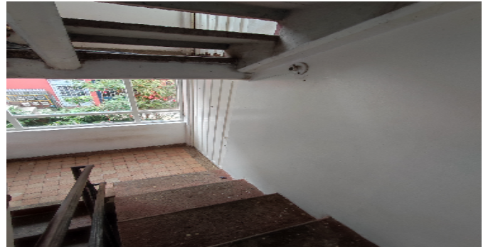
Escalera común CJ
