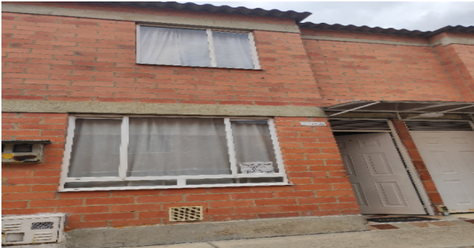
Fachada del Inmueble
