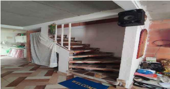
Escalera del inmueble
