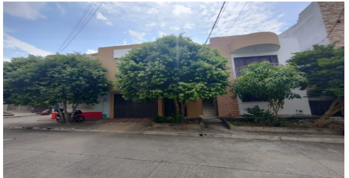
Fachada del Inmueble
