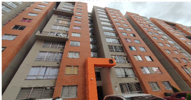
Fachada del Inmueble
