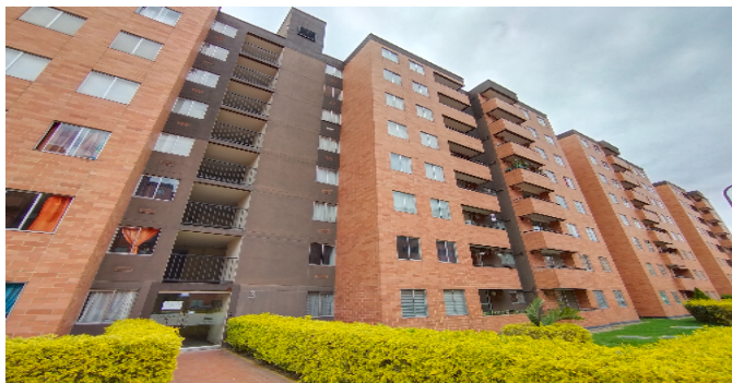
Fachada de la torre
