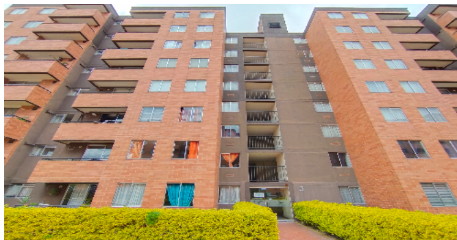
Fachada de la torre
