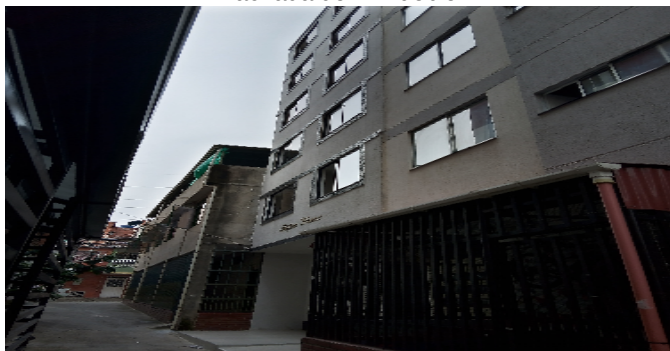
Fachada del Inmueble
