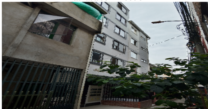
Fachada del Inmueble
