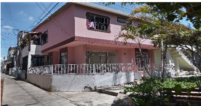
Fachada del Inmueble
