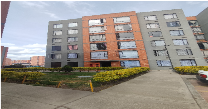
Fachada del Inmueble
