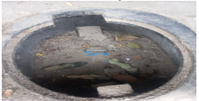
Contador de Agua
