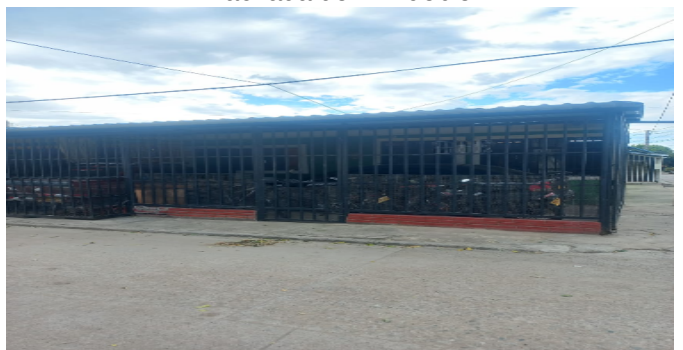
Fachada del Inmueble
