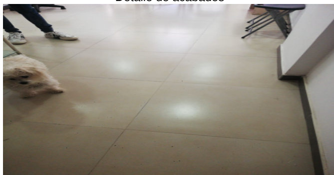
Detalle de acabados
