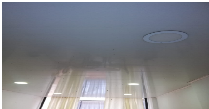
Detalle de acabados
