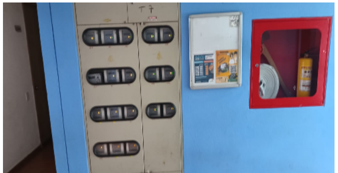
Contador de Gas
