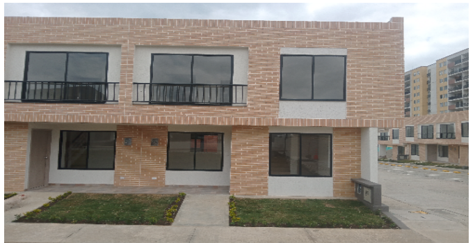
Fachada del Inmueble
