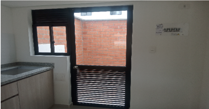
puerta hacia patio ropas
