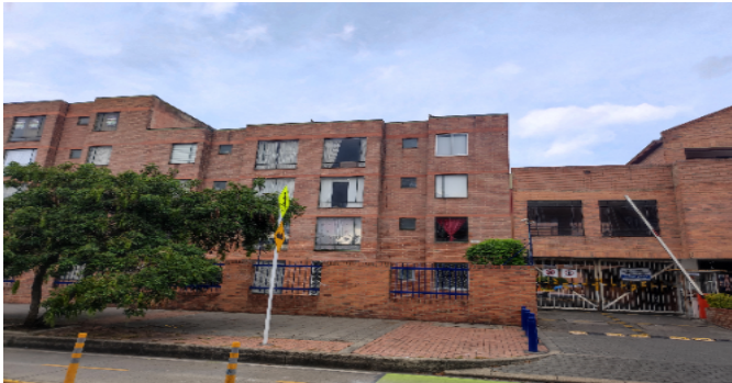
Fachada del Inmueble
