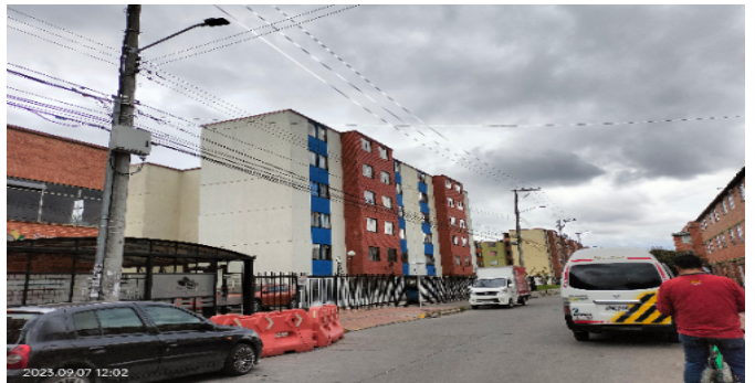
Fachada del Inmueble
