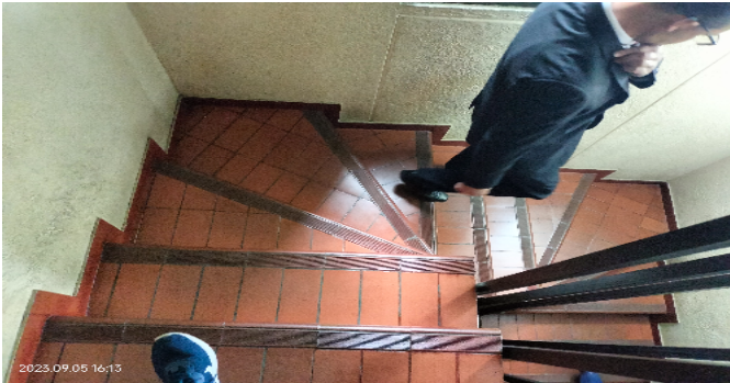
Escalera comn CJ
