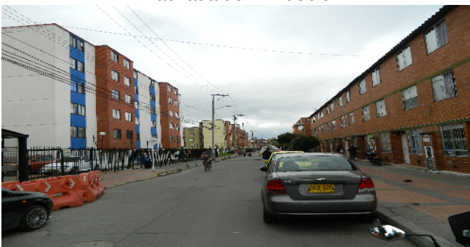
Fachada del Inmueble
