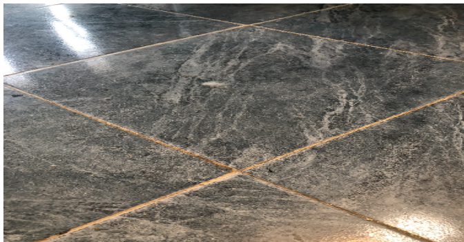
Detalle de acabados
