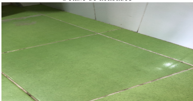
Detalle de acabados
