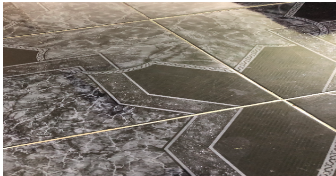
Detalle de acabados
