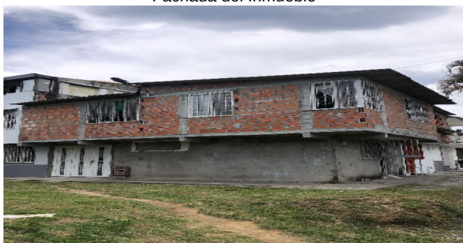
Fachada del Inmueble
