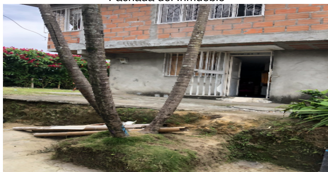
Fachada del Inmueble
