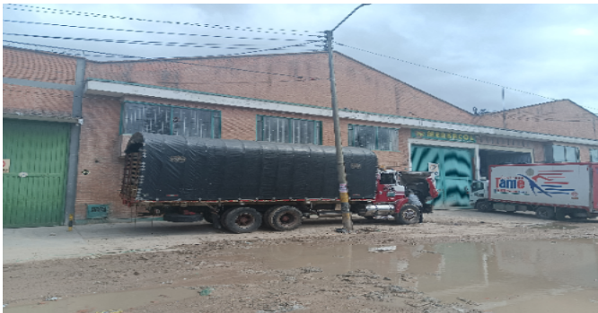
Fachada del Inmueble
