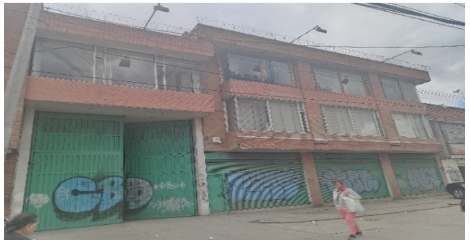
Fachada del Inmueble
