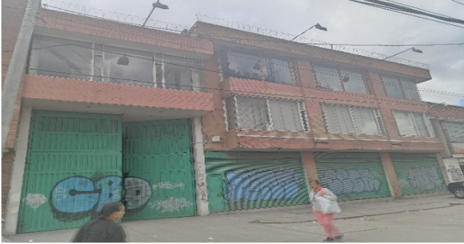
Fachada del Inmueble
