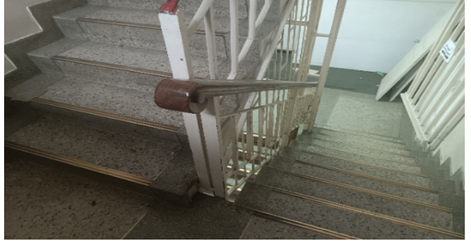
Escalera del inmueble
