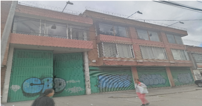
Fachada del Inmueble
