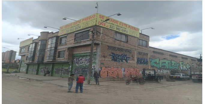
Fachada del Inmueble
