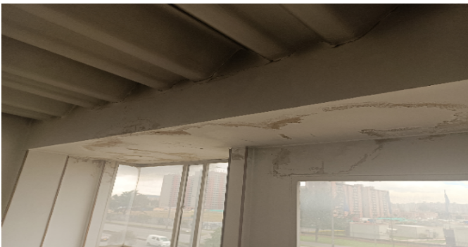
Detalle de acabados
