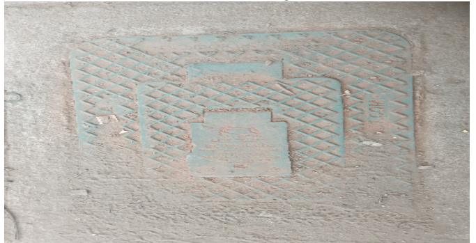
Contador de Agua
