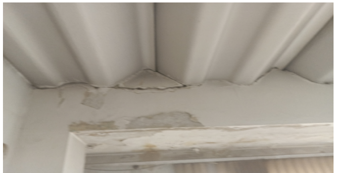
Detalle de acabados
