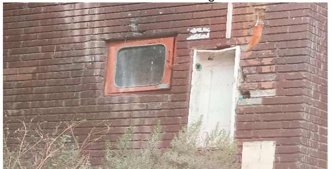
Contador de Energia
