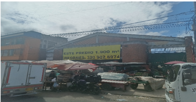
Fachada del Inmueble
