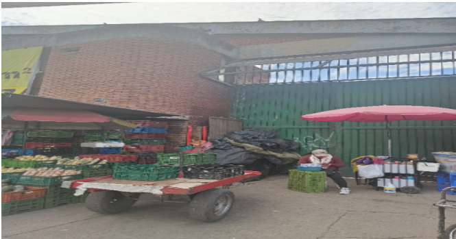
Fachada del Inmueble
