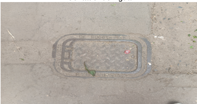
Contador de Agua
