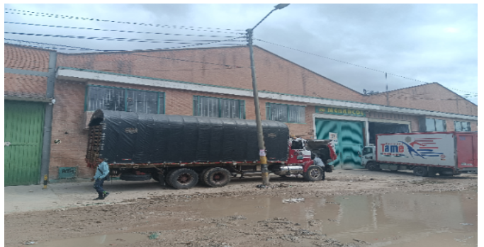
Fachada del Inmueble
