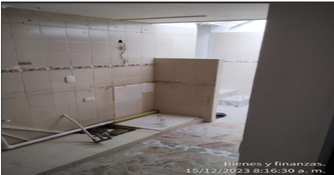
Cocina nivel 2 desmontada
