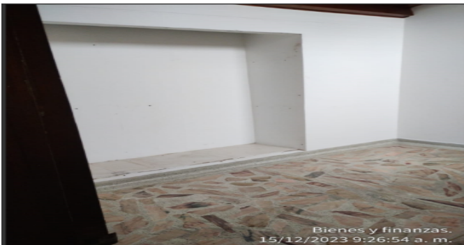
Closet Hab 5 desmontado
