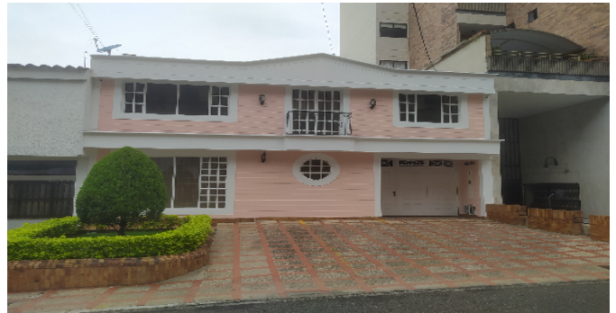
Fachada del Inmueble
