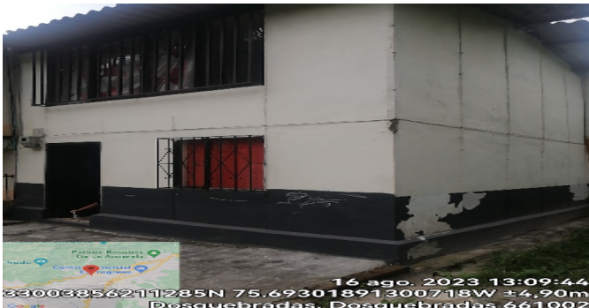
Fachada del Inmueble
