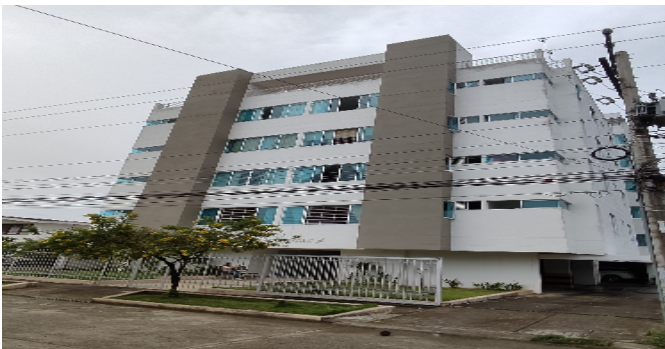
Fachada del Inmueble
