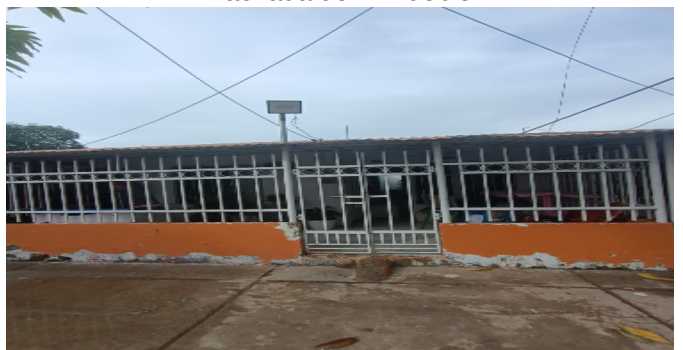
Fachada del Inmueble
