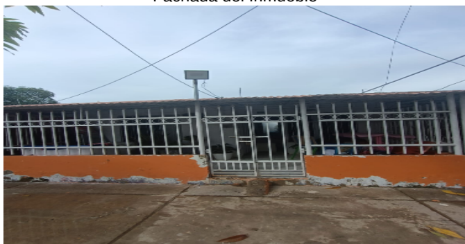
Fachada del Inmueble
