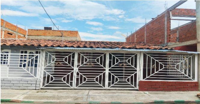
Fachada del Inmueble
