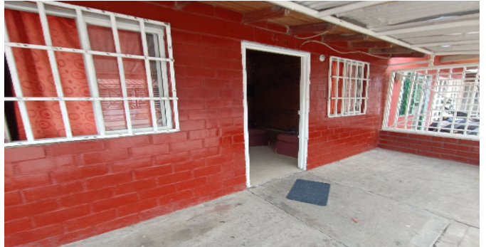
Fachada del Inmueble
