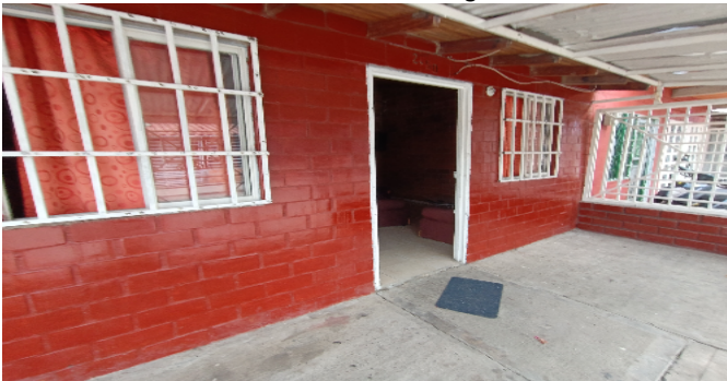
Contador de Energia
